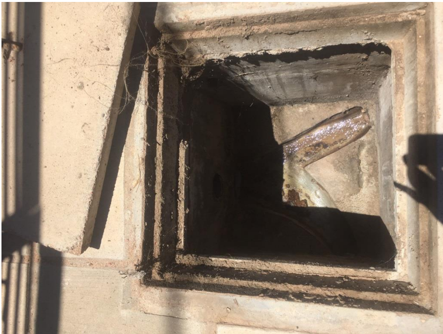
Cámara 1, abierta. Zampeados correctos de acuerdo a plano. Tiene doble tapa
