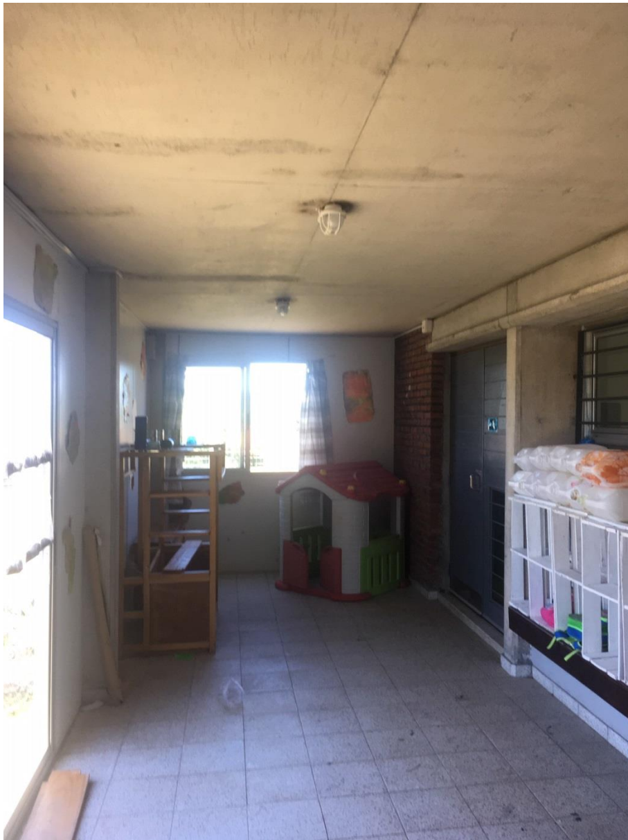
Cerramiento de isopanel realizado por el centro, ventana
