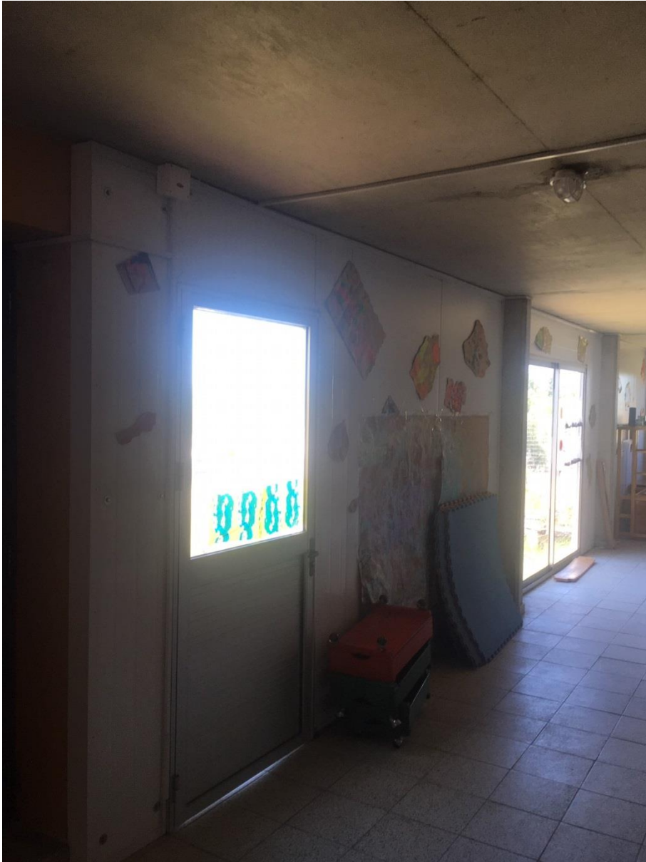
Cerramiento de isopanel realizado por el centro, puerta y puerta-ventana
