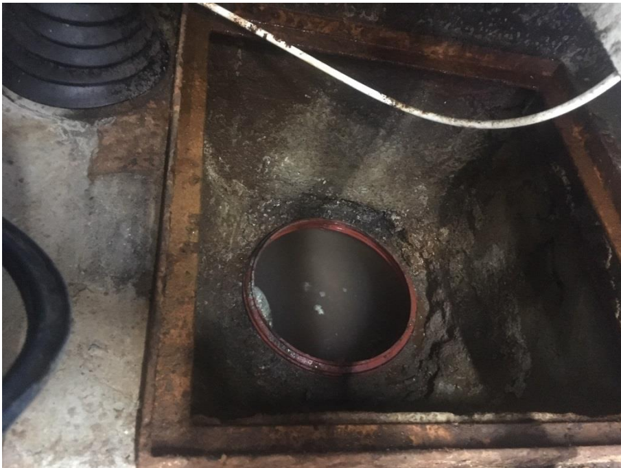
Sector bajo mesada con grasera, se puede ver gran presencia de humedad
