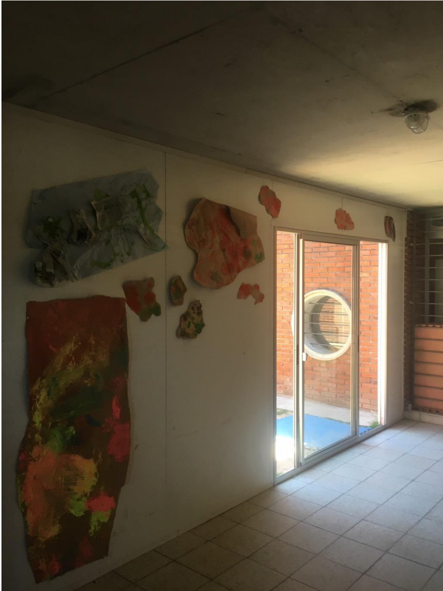
Cerramiento de isopanel realizado por el centro, puerta-ventana hacia patio
