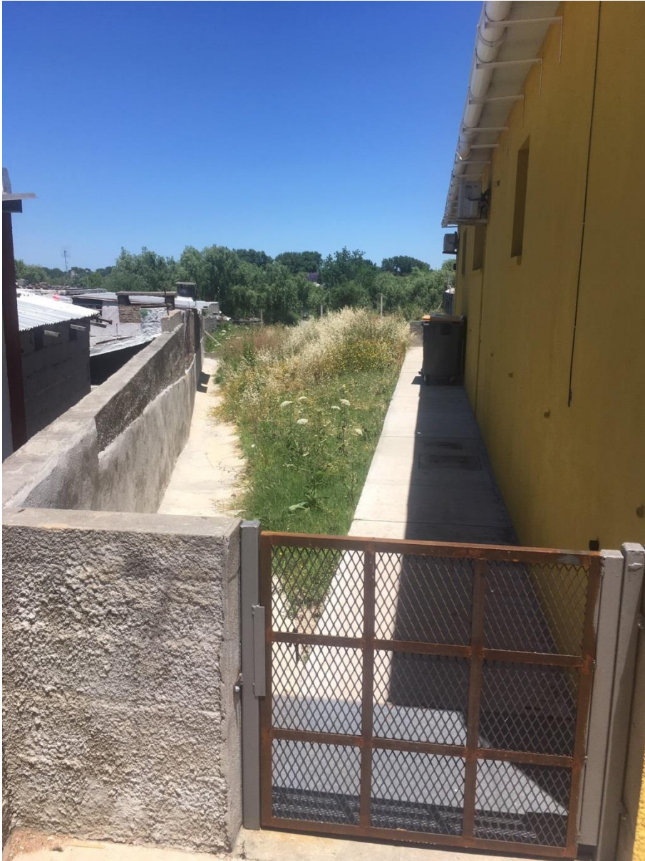
Foto de retiro lateral, se puede observar el canalón y la cuneta de HA que desagua los pluviales hacia el sector posterior
