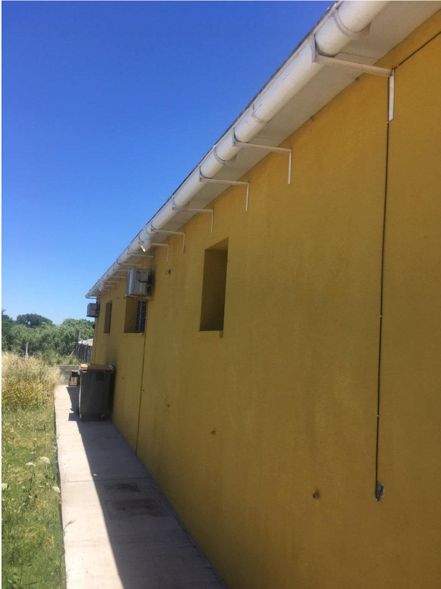
Canalón sin columnas de bajada
